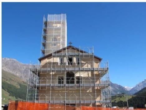
tanta umidità da sgretolare l'intonaco, sono stati riportati alla luce con un accurato lavaggio gli intonaci originali a base di calce scoprendo delle colorazioni che avevano toni più marcati sui piloni murari emergenti e più tenui sulle pareti.
